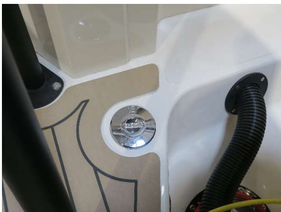
Nable de pompage eaux noires
