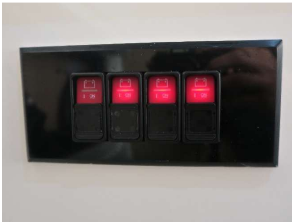
Commande à distance coupe-circuits principaux
