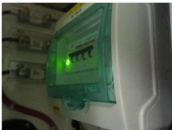
Disjoncteurs différentiels et principaux
